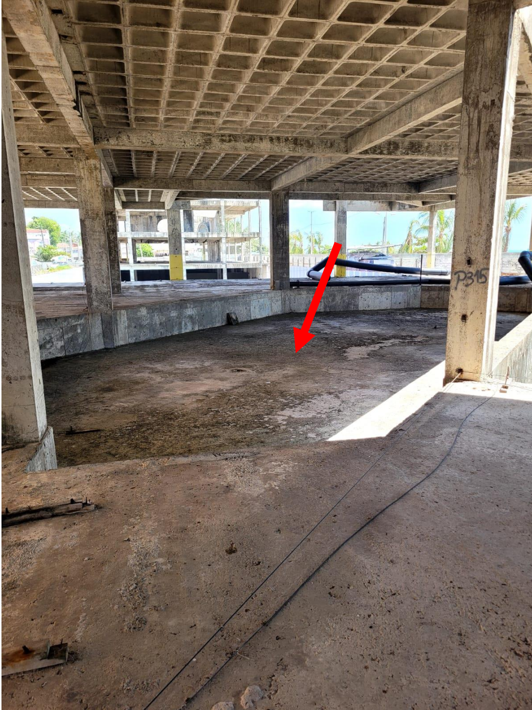
FOTO 29 – FECHAMENTO COM LAJE FLUTUANTE NO TETO DO PAV. TÉRREO
