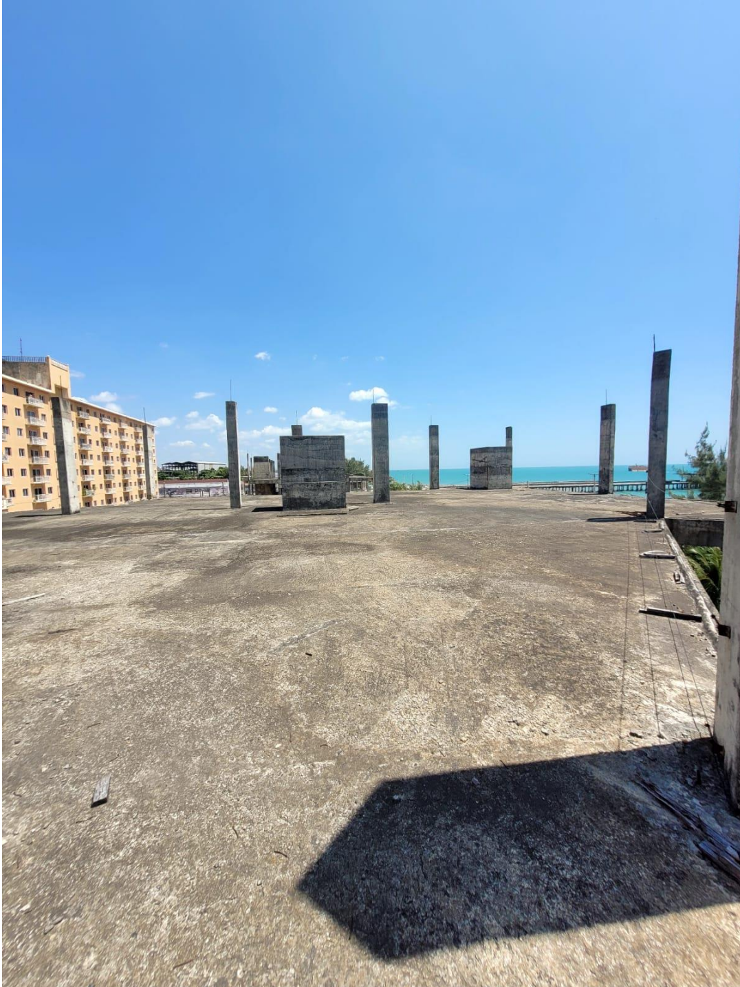
FOTO 39 – EXECUÇÃO NOVA LAJE TETO DO 3º. PAVIMENTO E DEMOLIÇÃO DAS CAIXAS DE CONCRETO
