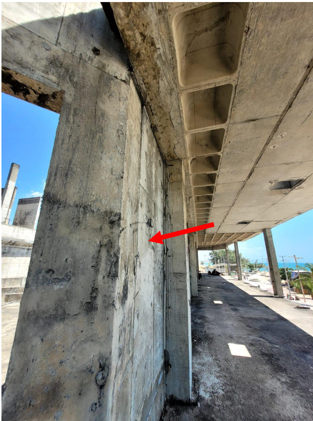
FOTO 44 – DEMOLIÇÃO DE PAREDES DE CONCRETO DO TÚNEL DO AQUÁRIO
