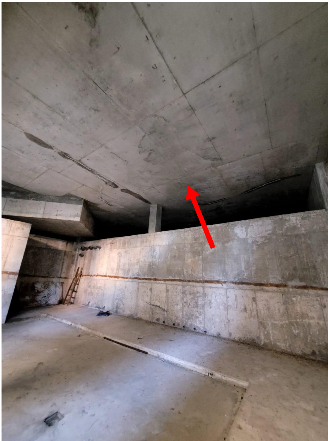
FOTO 03 – LAJE MACIÇA TETO SUBSOLO APOIO DA AMPLIAÇÃO
