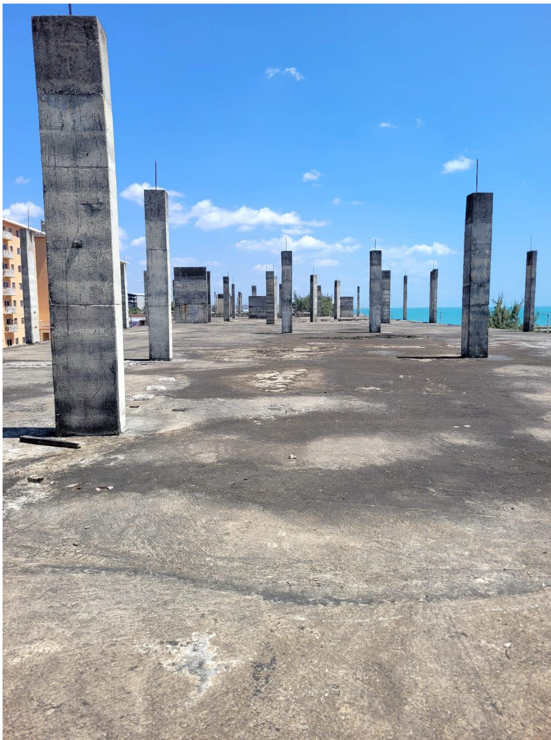
FOTO 35 – EXECUÇÃO NOVA DO TETO DO 3º. PAVIMENTO
