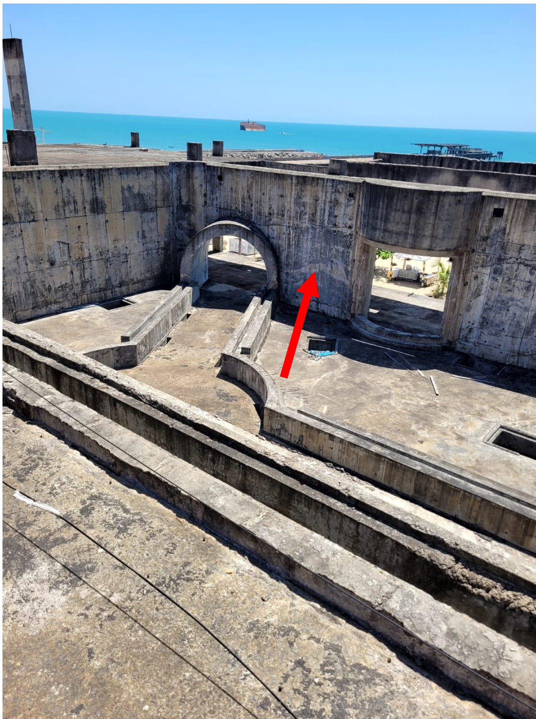
FOTO 47 – DEMOLIÇÃO DE PAREDES DE CONCRETO DO TÚNEL DO AQUÁRIO
