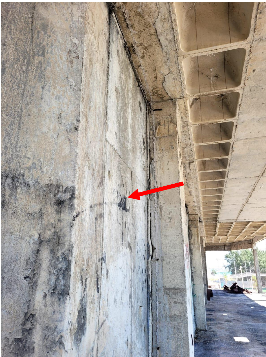
FOTO 45 – DEMOLIÇÃO DE PAREDES DE CONCRETO DO TÚNEL DO AQUÁRIO
