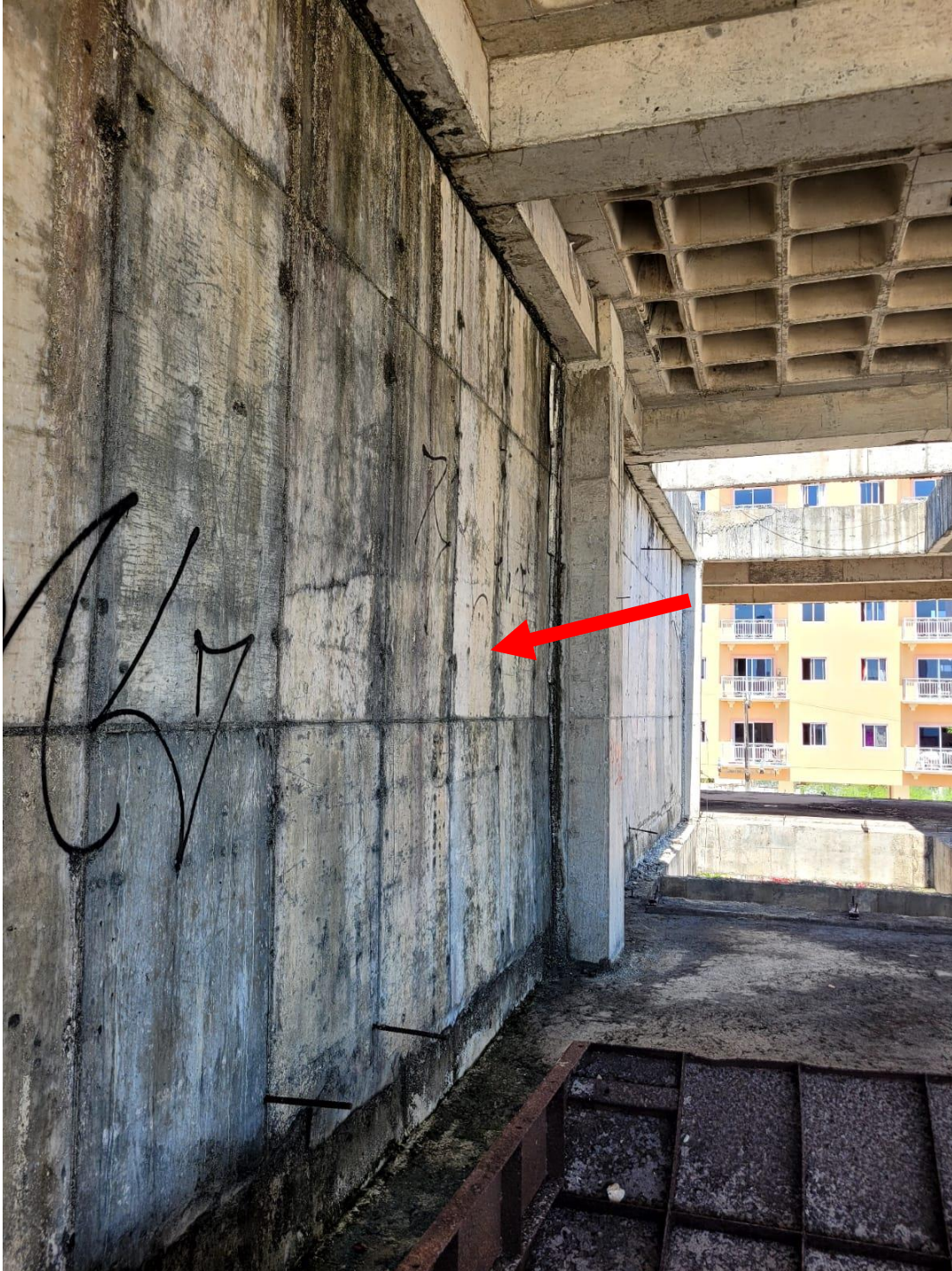
FOTO 46 – DEMOLIÇÃO DE PAREDES DE CONCRETO DO TÚNEL DO AQUÁRIO
