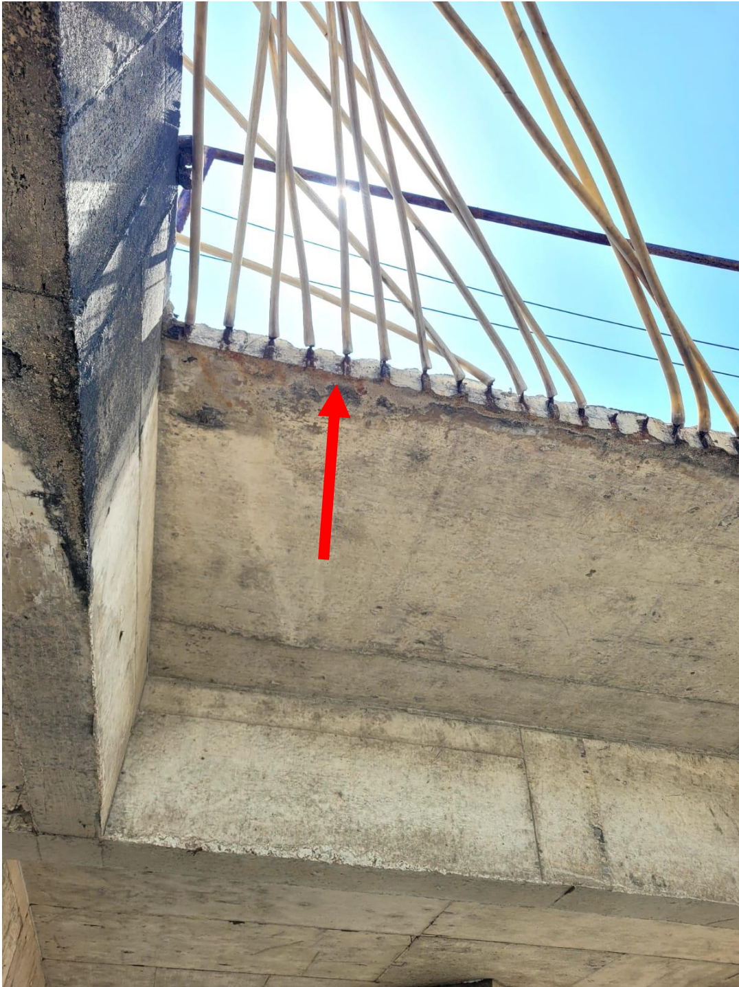
FOTO 37 – ARMADURA DE ESPERA DE UMA LAJE
