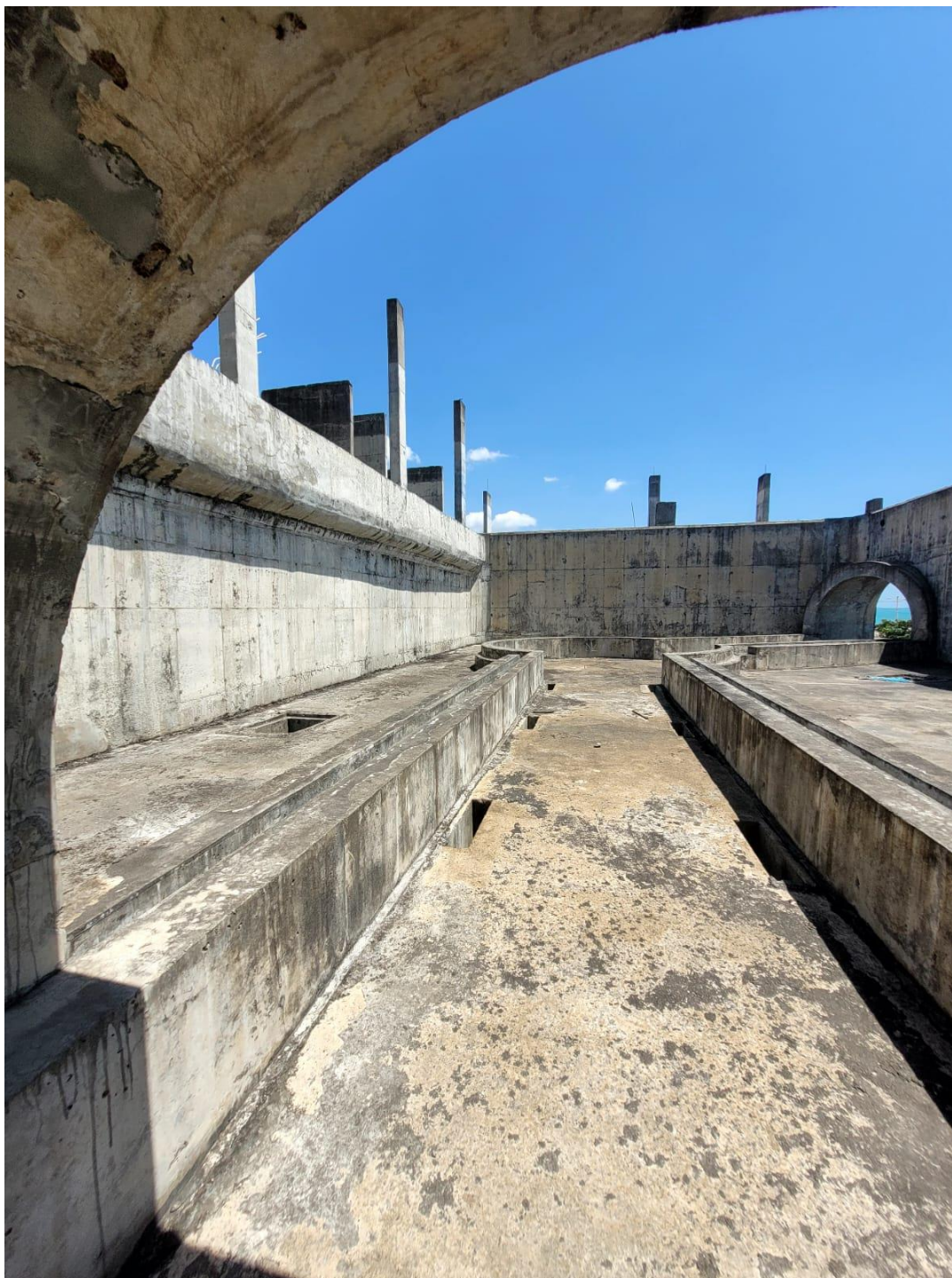
FOTO 42 – DEMOLIÇÃO DE PAREDES DE CONCRETO DO TÚNEL DO AQUÁRIO
