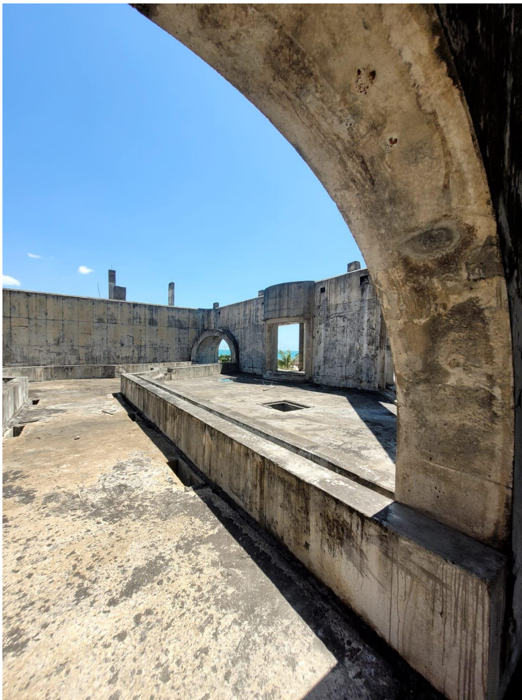
FOTO 43 – DEMOLIÇÃO DE PAREDES DE CONCRETO DO TÚNEL DO AQUÁRIO
