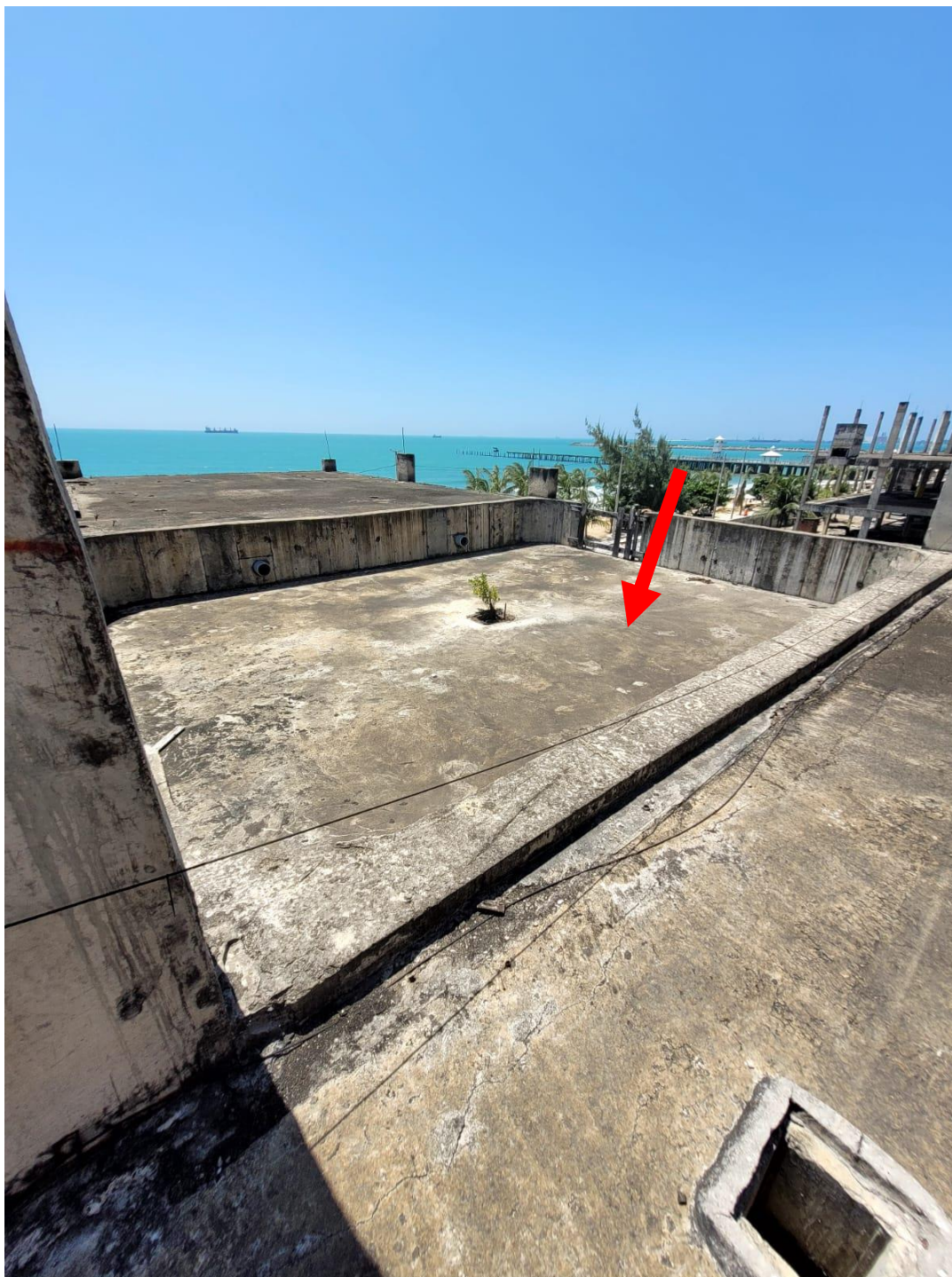
FOTO 49 – FECHAMENTO COM LAJE FLUTUANTE DO TETO DO 2º. PAVIMENTO
