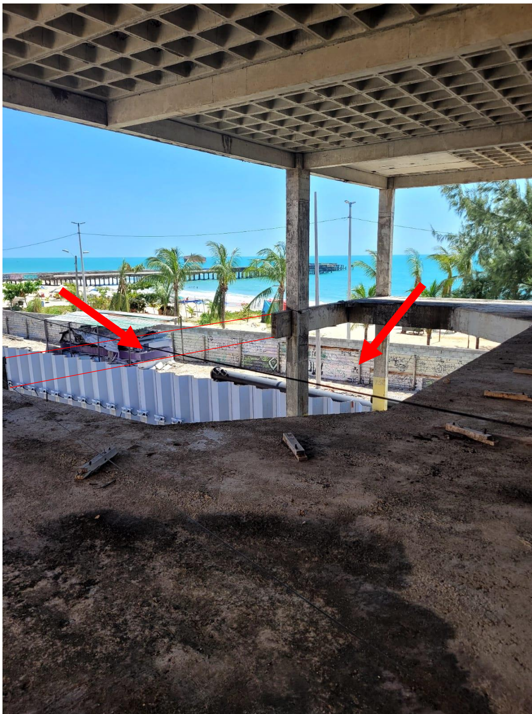
FOTO 32 – FECHAMENTO COM VIGA NOVA E LAJE NERVURADA NO TETO DO PAV. TÉRREO
