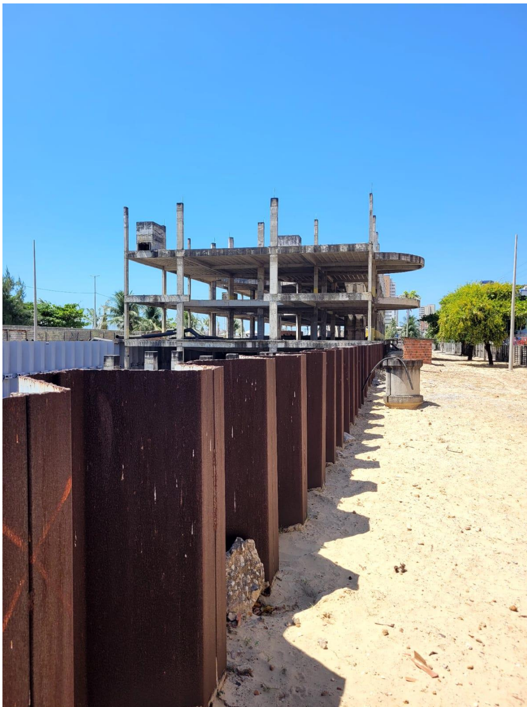
FOTO 57 – CONTINUIDADE DA VIGA DE COROAMENTO DAS CONTENÇÕES; VERIFICAR PINTURA PROTETIVA NOS TRECHOS EXTERNOS DA CONTENÇÃO METÁLICA
