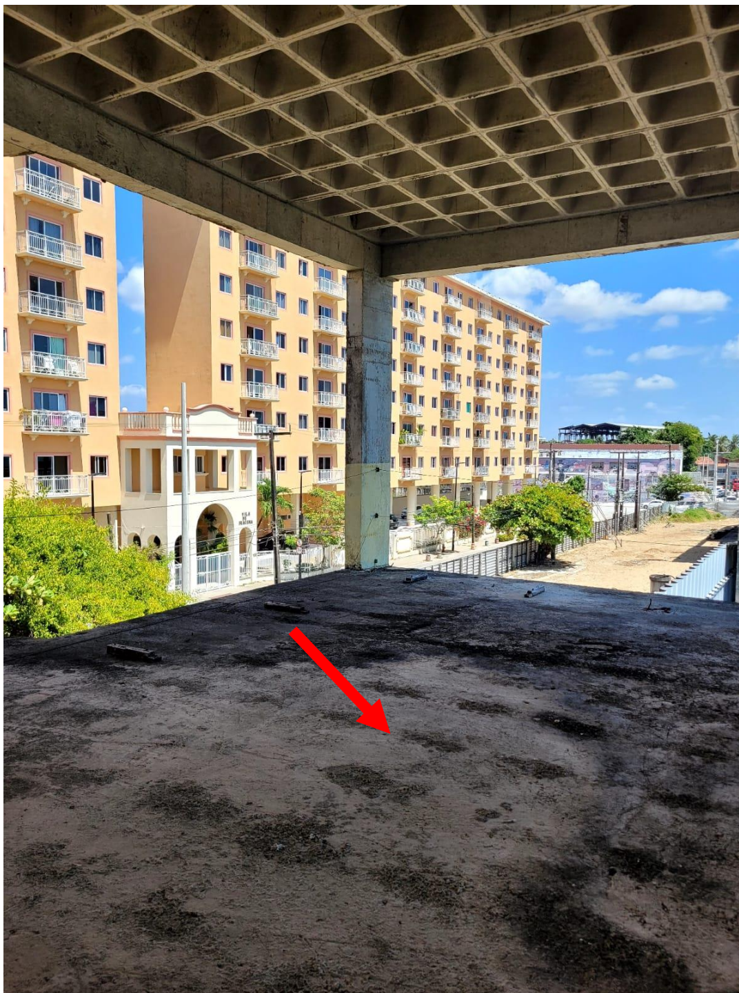
FOTO 33 – ABERTURA NA LAJE PARA PASSAGEM DE UM ELEVADOR NO TETO DO 1º. PAVIMENTO
