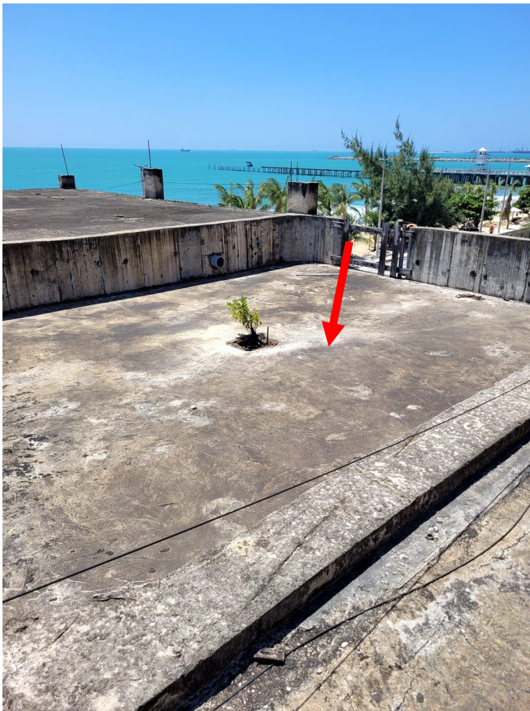
FOTO 50 – FECHAMENTO COM LAJE FLUTUANTE DO TETO DO 2º. PAVIMENTO
