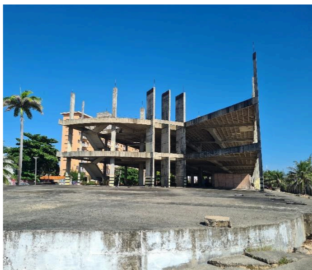
Figura 3: Remanescente estrutural em concreto a ser mantido e utilizado. Fonte: Acervo UFC
