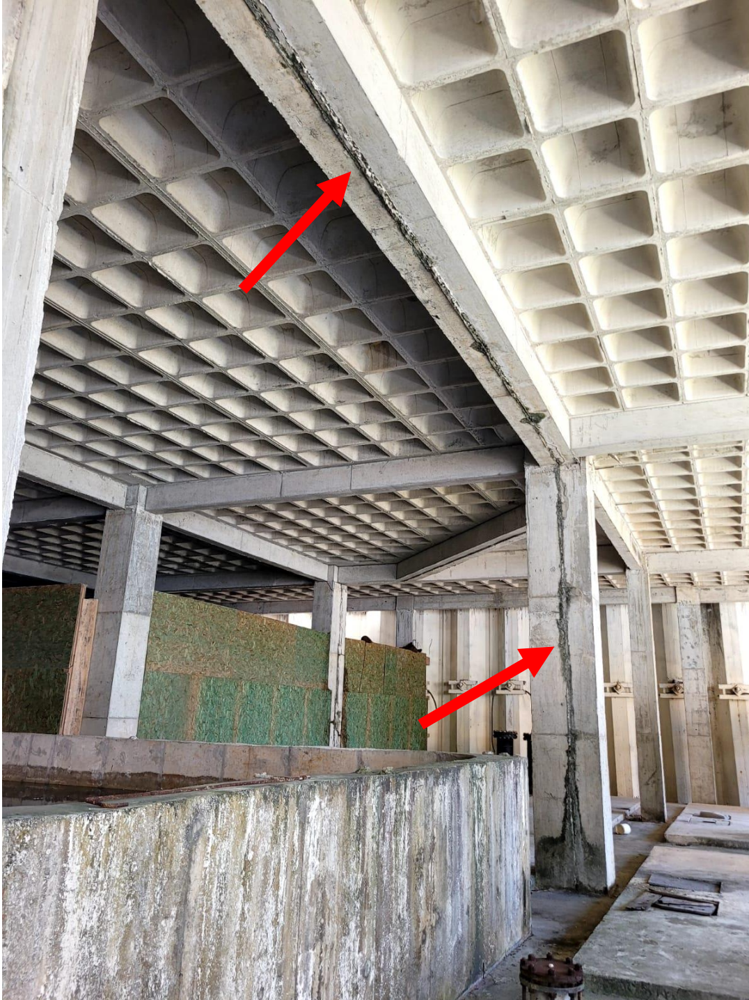
FOTO 15 – JUNTA DE ELEMENTOS DIVIDIDOS NO TRECHO 1 AQUÁRIO COM TÚNEL A SER DEMOLIDO
