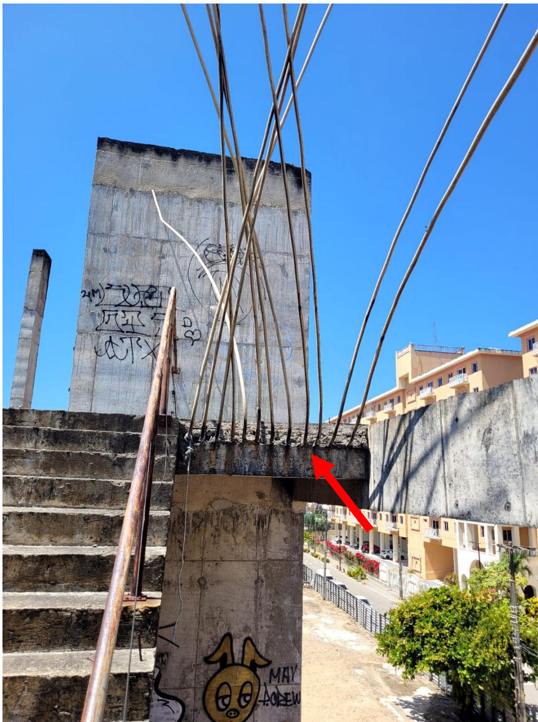
FOTO 52 – ARMADURA DE ESPERA DA ESCADA DE ACESSO AO TETO DO 3º. PAVIMENTO
