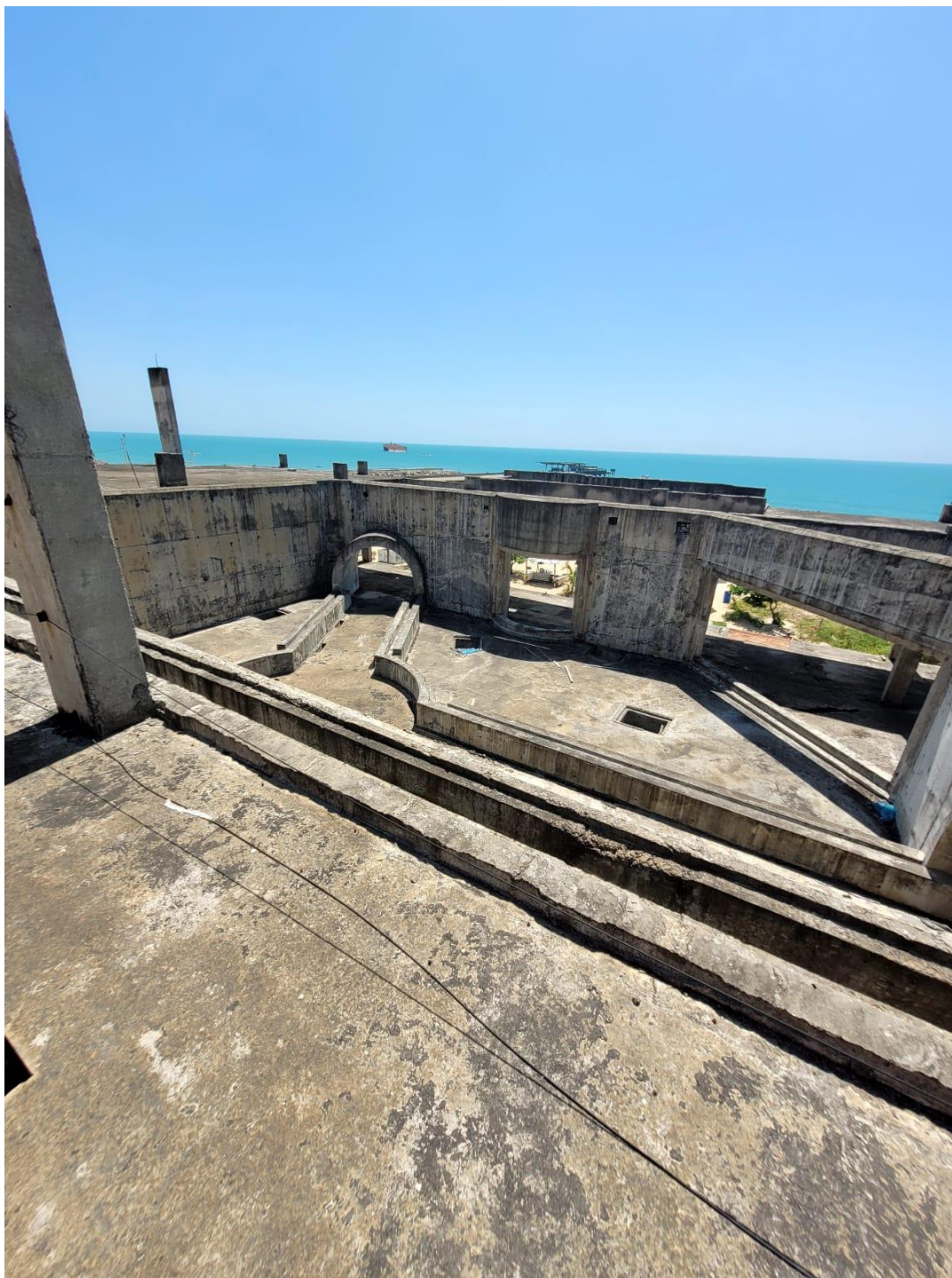
FOTO 48 – DEMOLIÇÃO DE PAREDES DE CONCRETO DO TÚNEL DO AQUÁRIO
