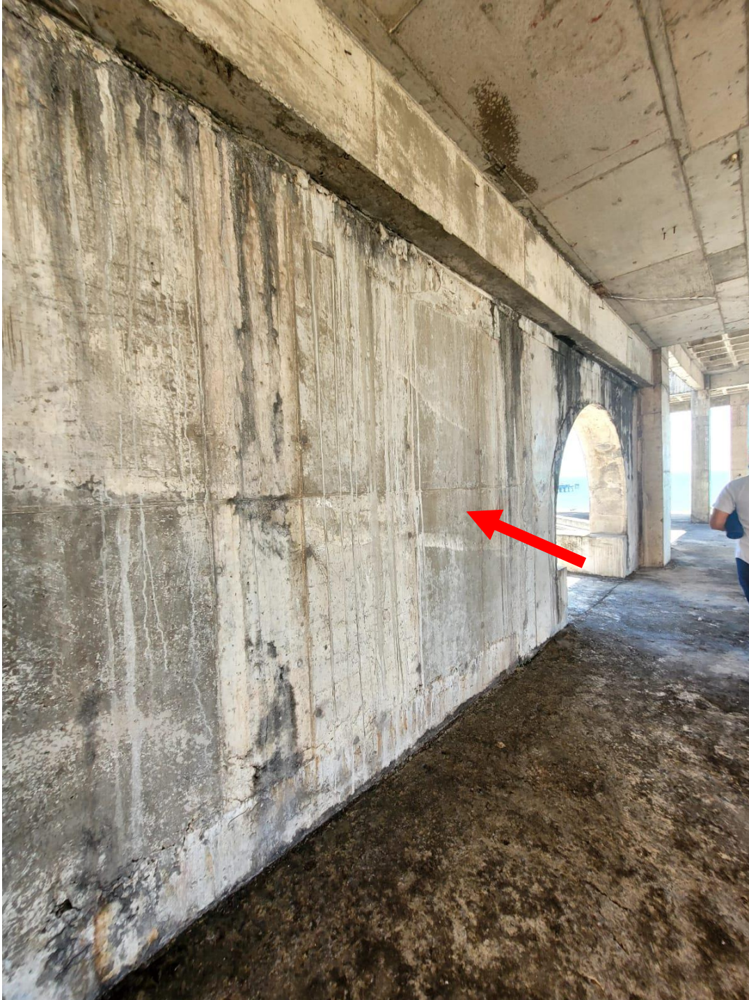
FOTO 41 – DEMOLIÇÃO DE PAREDES DE CONCRETO DO TÚNEL DO AQUÁRIO
