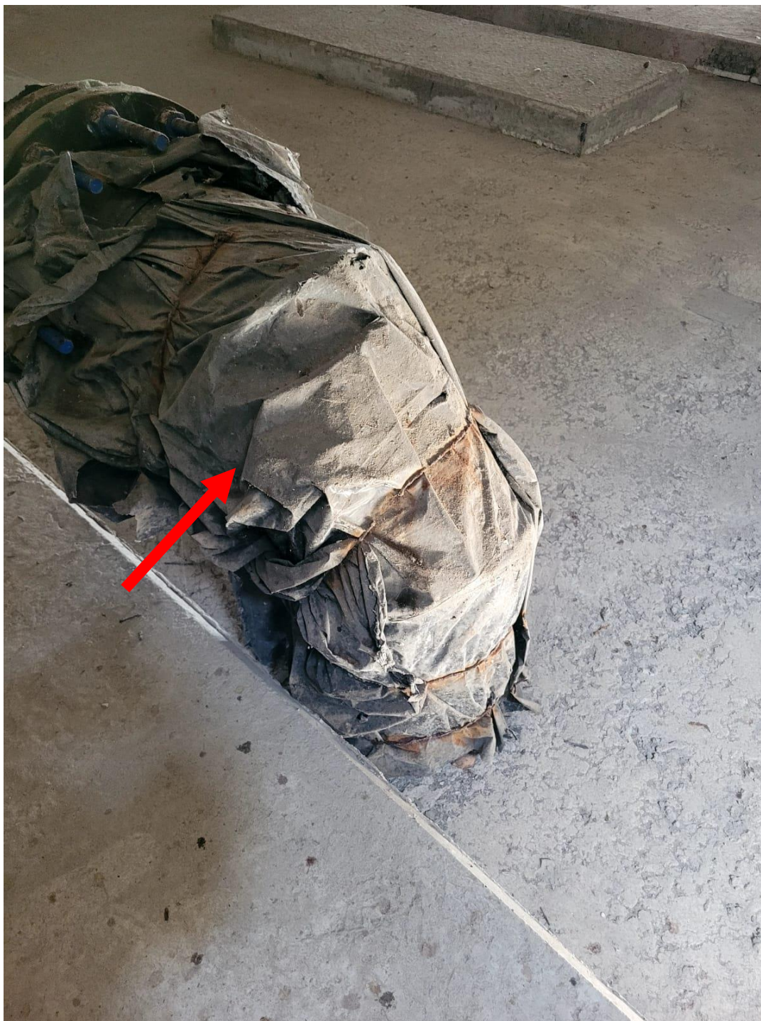
FOTO 09 – TUBULAÇÕES NO TETO DO PAV. TÉCNICO QUE SERÃO RETIRADAS E ABERTURAS FECHADAS COM LAJE MACIÇA: H=14
