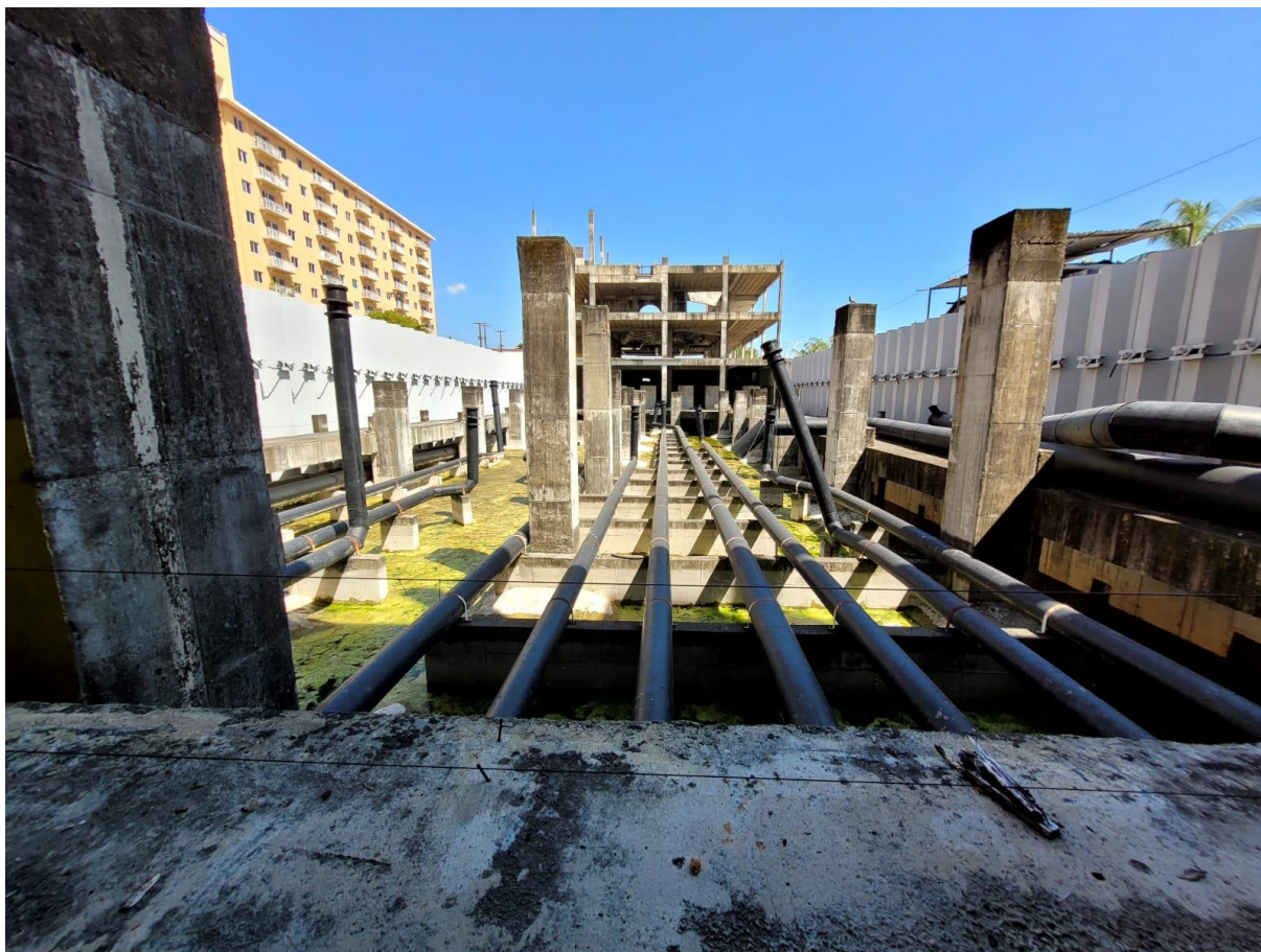
FOTO 11 – DORMENTES E PILARES QUE SERÃO RETIRADOS E NOVAS LAJES SOBRE ESSE TRECHO - AUDITÓRIO
