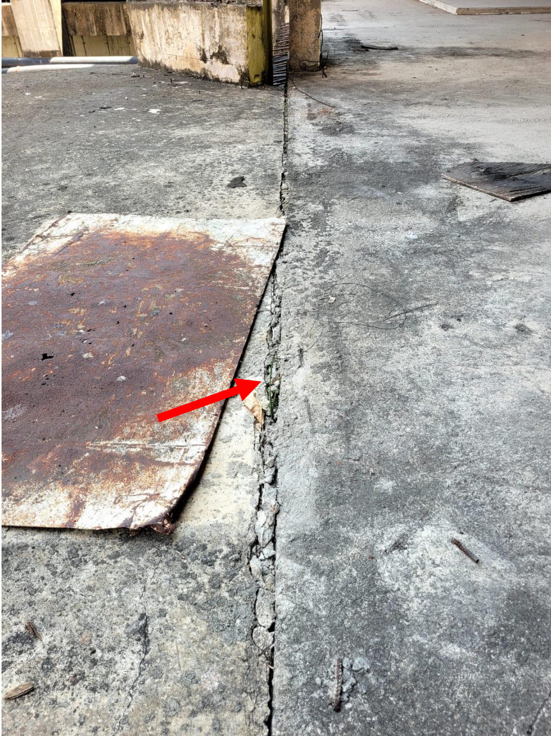
FOTO 12 – REALIZAR LIMPEZA E ACABAMENTO NAS JUNTAS DE DILATAÇÃO
