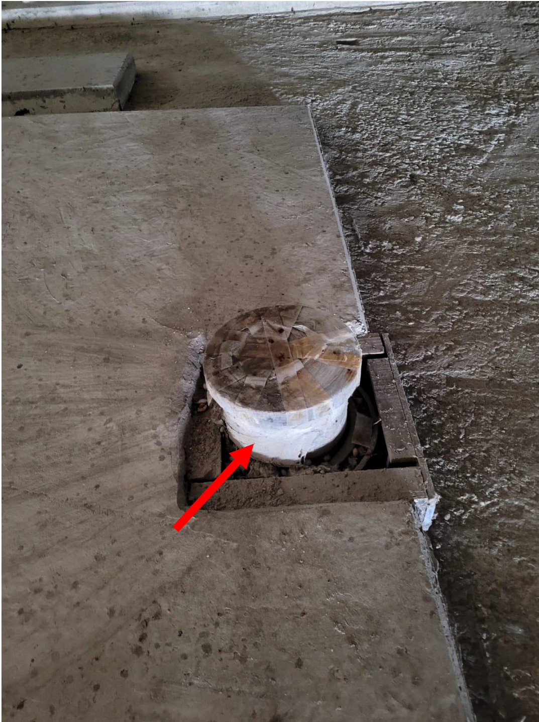
FOTO 08 – TUBULAÇÕES NO TETO DO PAV. TÉCNICO QUE SERÃO RETIRADAS E ABERTURAS FECHADAS COM LAJE MACIÇA: H=14
