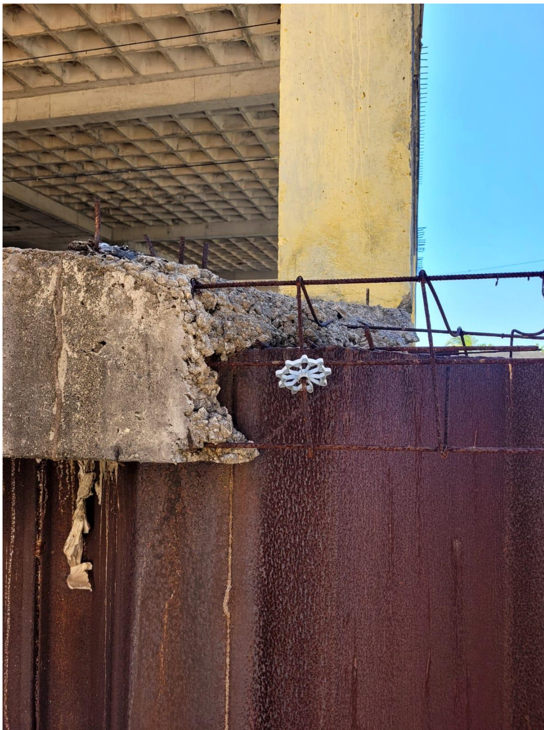
FOTO 56 – CONTINUIDADE DA VIGA DE COROAMENTO DAS CONTENÇÕES
