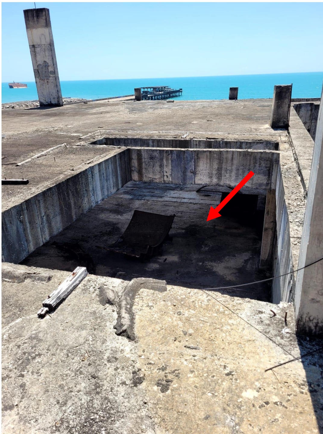
FOTO 51 – FECHAMENTO COM LAJE MACIÇA NO TETO DO 2º. PAVIMENTO
