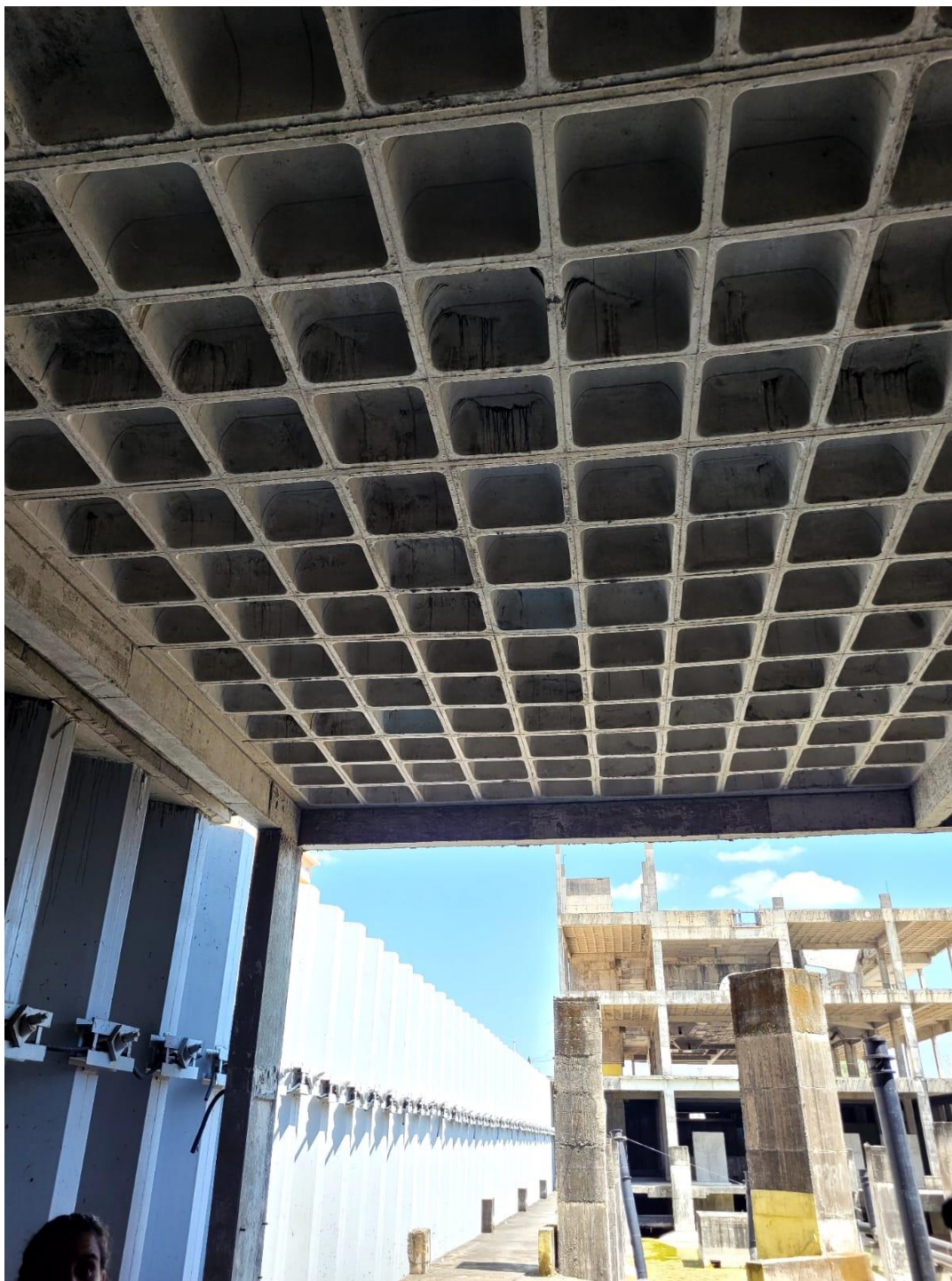
FOTO 24 – ABERTURA EM LAJE DE TETO DO PAV. TÉRREO - INCLUSÃO DE VIGAS EM CONCRETO
