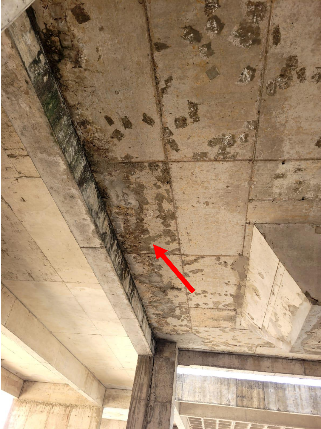
FOTO 55 – VERIFICAÇÃO DA LAJE DE FUNDO DO TÚNEL DO AQUÁRIO - VIDE VIGAS FAIXAS NAS BORDAS OU PROTENSÃO DA LAJE
