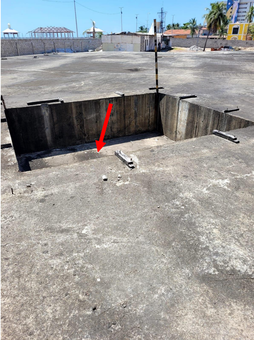
FOTO 30 – FECHAMENTO COM LAJE FLUTUANTE NO TETO DO SUBSOLO
