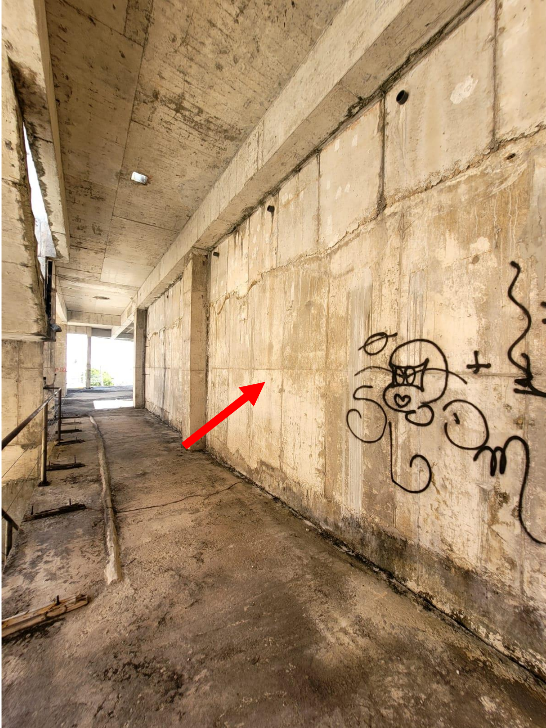
FOTO 40 – DEMOLIÇÃO DE PAREDES DE CONCRETO DO TÚNEL DO AQUÁRIO
