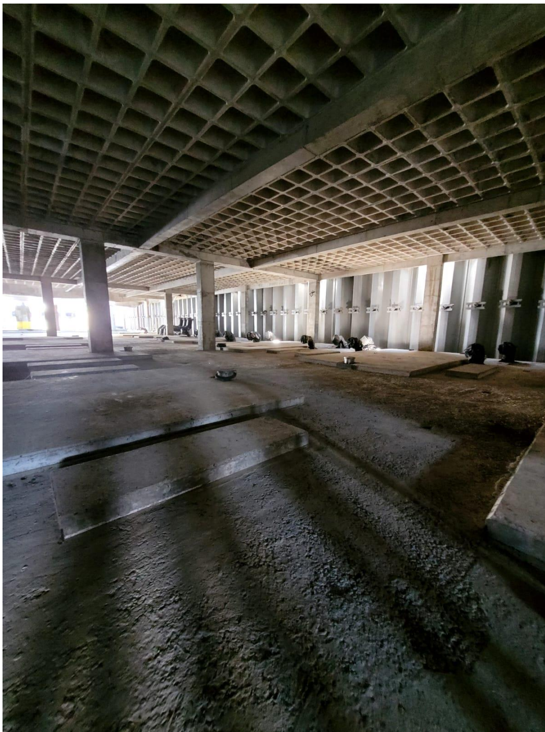
FOTO 07 – BASES APOIADAS SOBRE O TETO DO PAV.TÉCNICO QUE SERÃO DEMOLIDAS
