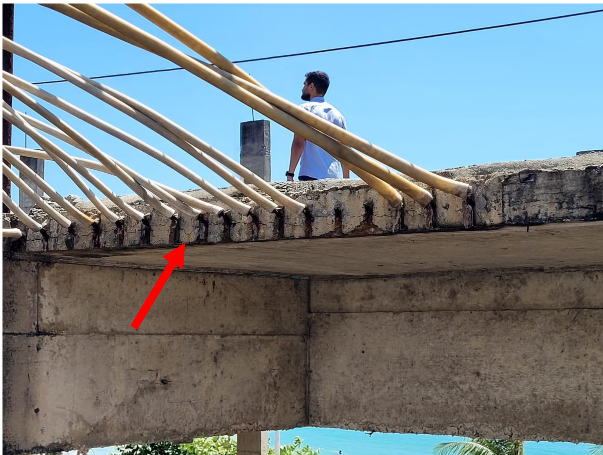
FOTO 38 – ARMADURA DE ESPERA DE UMA LAJE
