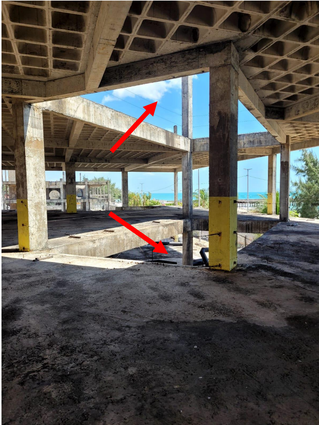
FOTO 31 – FECHAMENTO DAS LAJES DE TETO DO PAV. TÉRREO – 1º. PAVIMENTO E 2º. PAVIMENTO
