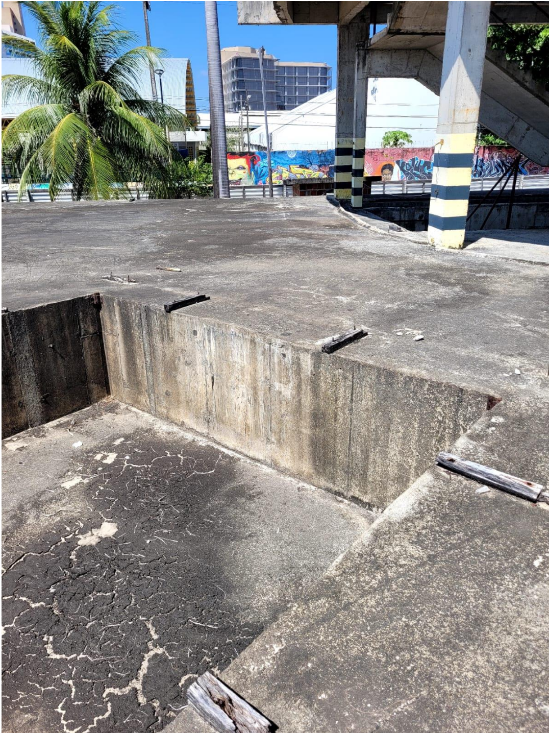
FOTO 01 – FECHAMENTO DA LAJE COM PISO FLUTUANTE PAV. TÉRREO
