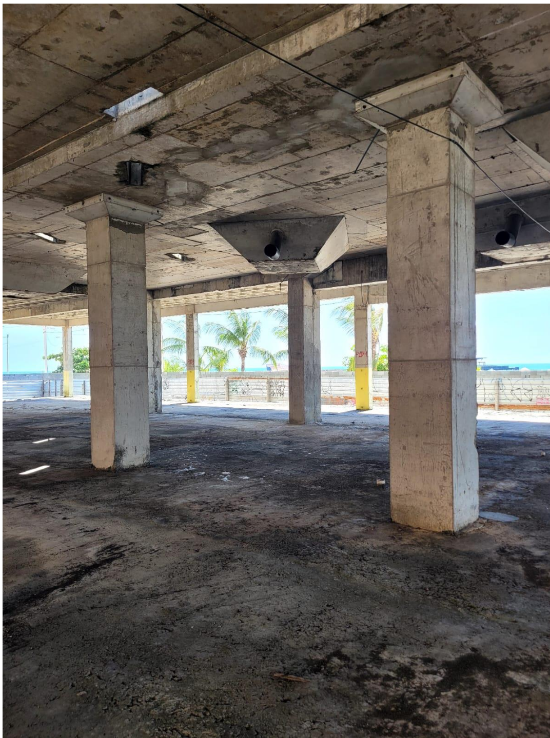
FOTO 54 – PROLONGAMENTO DOS PILARES DO TÚNEL DO AQUÁRIO PARA A NOVA LAJE DE TETO DO 2º. PAVIMENTO
