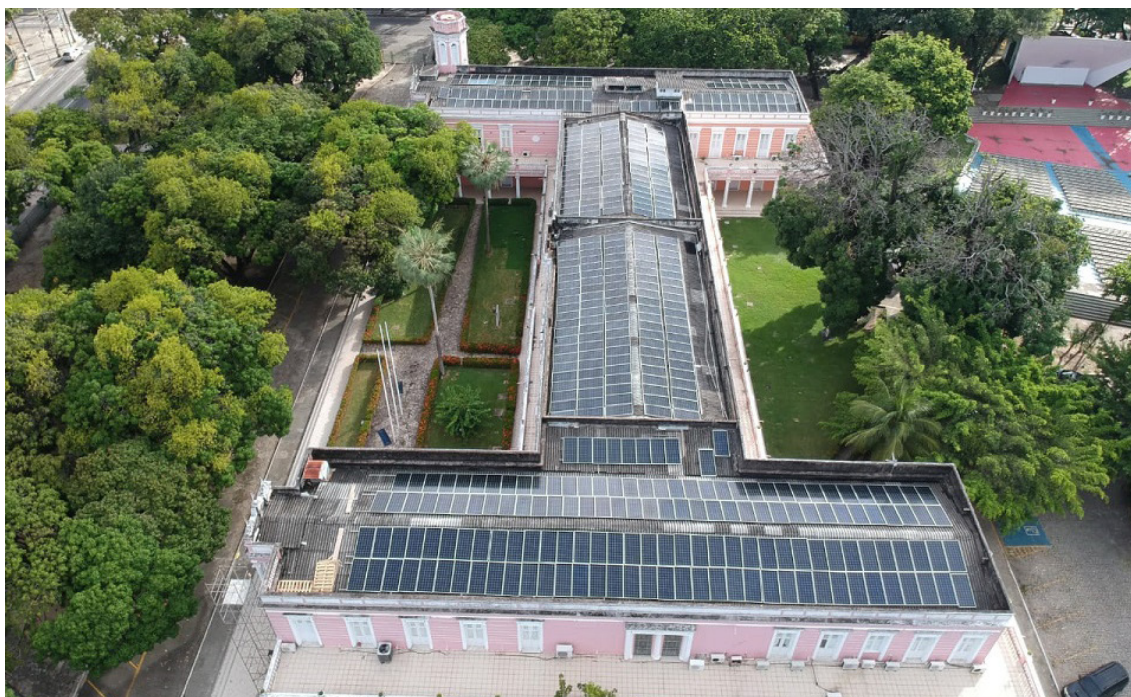
Placas fotovoltaicas instaladas na Reitoria da UFC.
